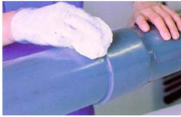
10.- En tuberías de diámetro mayor a 150 mm. Es aconsejable utilizar un aparato de ensamble a presión.
