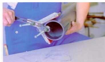
3.- Introduzca la tubería y marque con un lápiz en el tubo la profundidad a insertar dentro del casquillo para obtener las medidas de la superficie a pegar.
